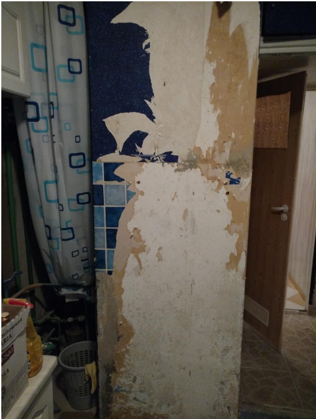
Kuchnia – zrywanie tapet, dziura z pionem wodno-kanalizacyjnym.
