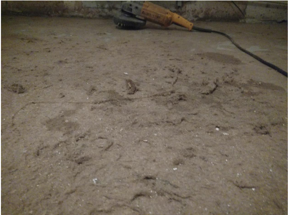
Usuwanie „miśka” pozostającego po zrywaniu wykładzin sztucznych z podłóg.
