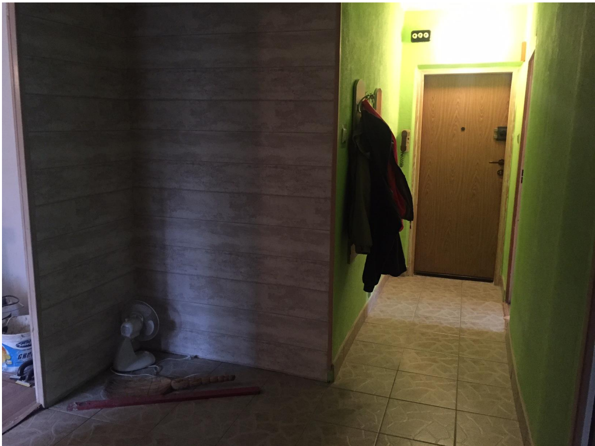
Przedpokój – na ścianach miejscami 3 warstwy tapety, na suficie piankowe kasetony.
